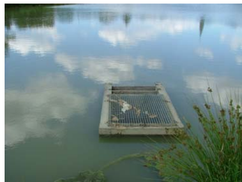
Figure 2 : photo d'un moine muni d'une grille.
