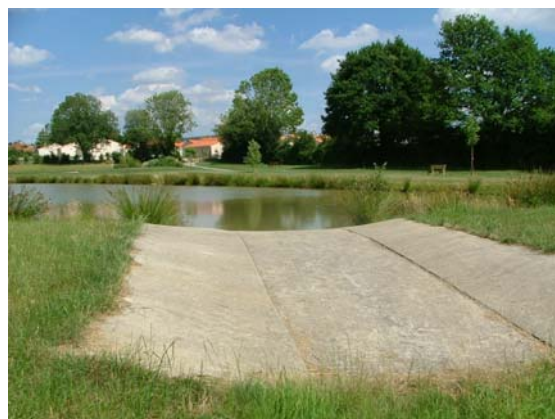
Figure 6 : photo d'un déversoir
